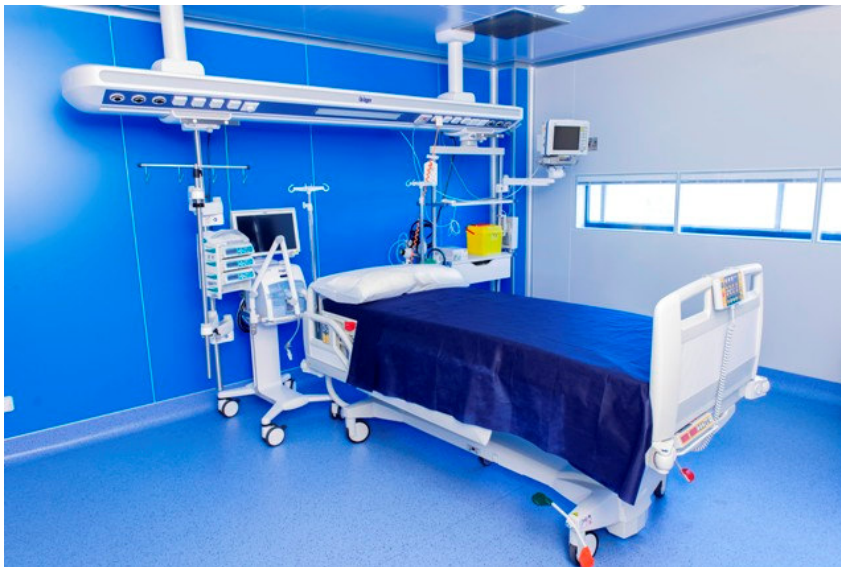
HABITACION DE ALTO NIVEL DE SEGURIDAD BIOLÓGICA
