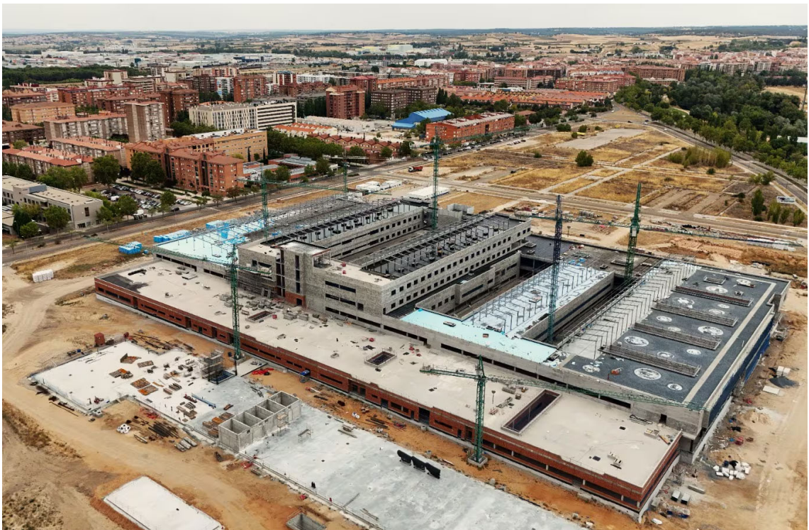
Casetón de Instalaciones.
