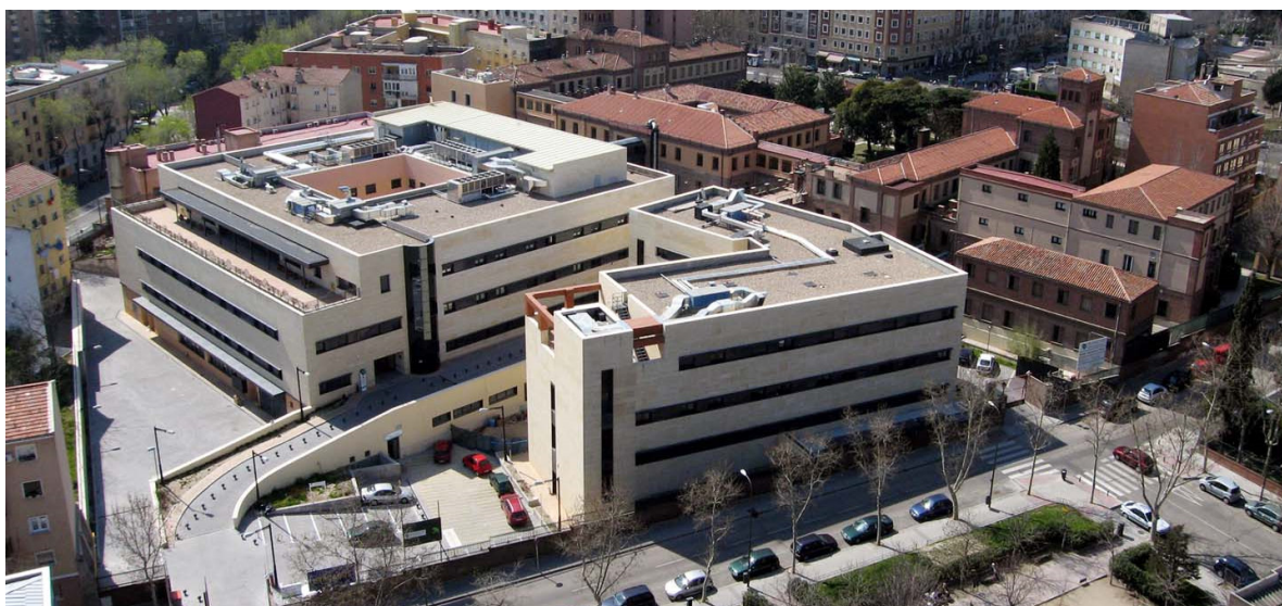
VISTA AEREA DEL CONJUNTO FORMADO POR EL HOSPITAL
