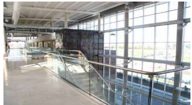
DETALLE DEL MURO CORTINA DE LA FACHADA PRINCIPAL
