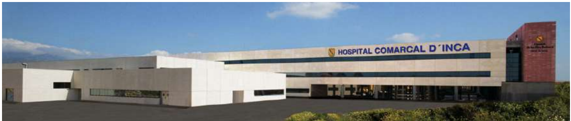
ACCESO A URGENCIAS DEL NUEVO HOSPITAL
