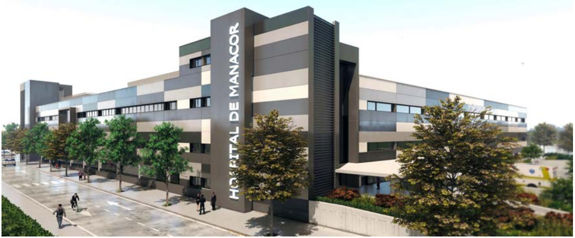
FACHADA DEL NUEVO EDIFICIO DE CONSULTAS EXTERNAS.
