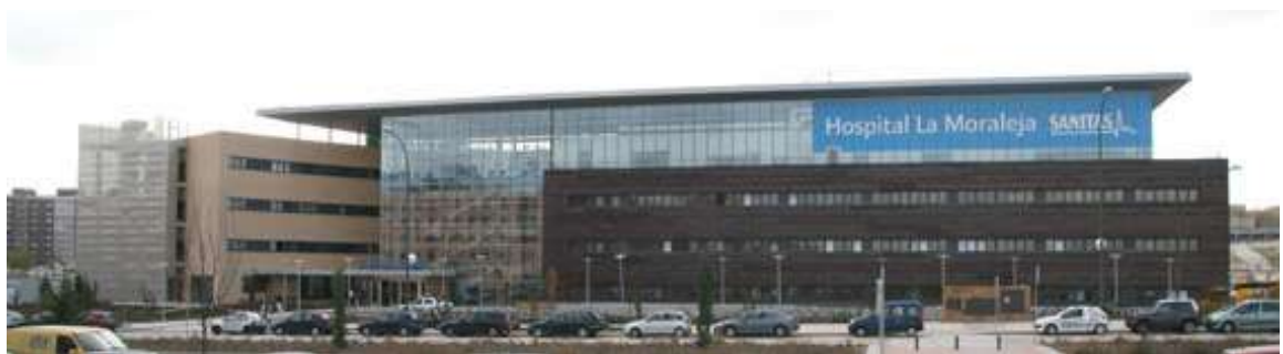
VISTA DE LA FACHADA PRINCIPAL DEL HOSPITAL "LA MORALEJA"
