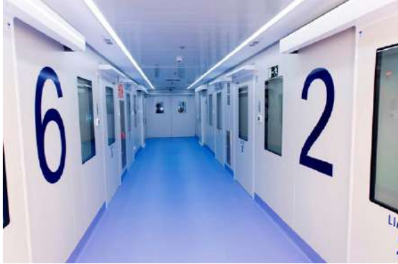
VISTA GENERAL DEL PASILLO DE LA UAAN
