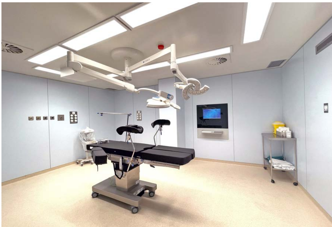
ETAPA I_SALA TECNICA - UTPR
