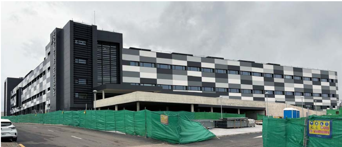
Estado de las Obras Enero 2026
