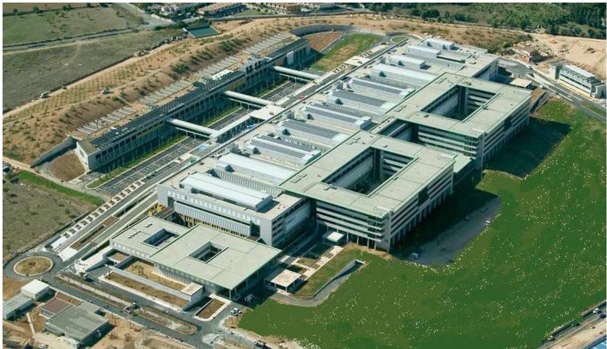
VISTA AEREA DEL ESTADO FINAL DE LAS OBRAS
