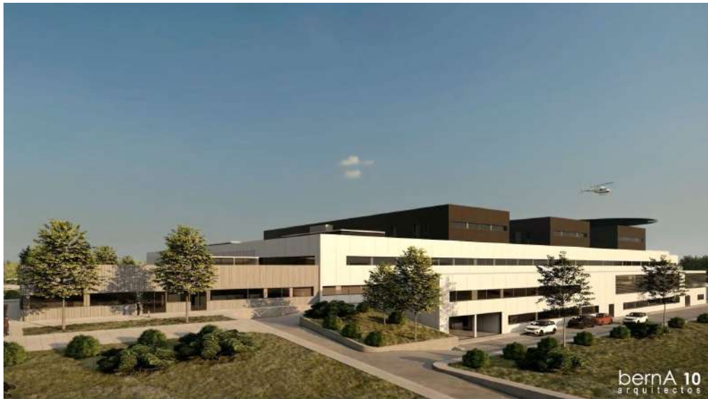
FACHADA DEL NUEVO EDIFICIO DE CONSULTAS EXTERNAS.
