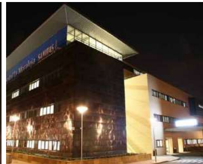
VISTA NOCTURNA DE LA FACHADA PRINCIPAL Y DEL ACCESO A URGENCIAS EN LAS QUE SE MANIFIESTA LA TRANSPARENCIA DEL EDIFICIO
