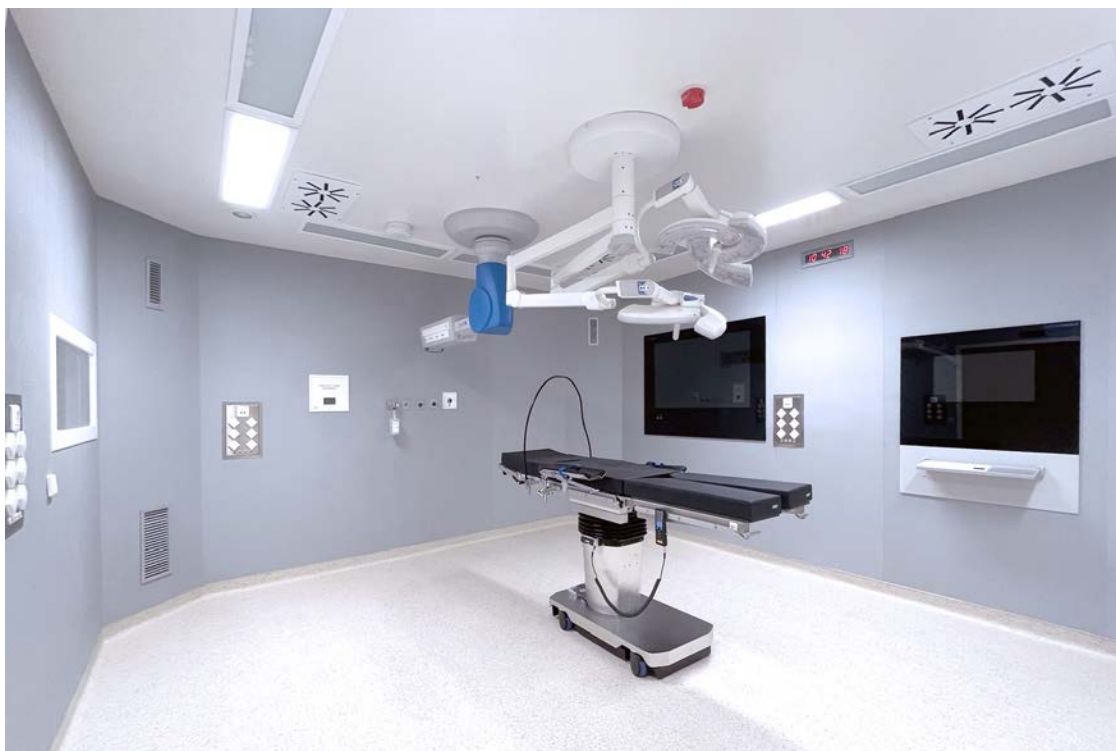
ETAPA II Quirófano CMA
