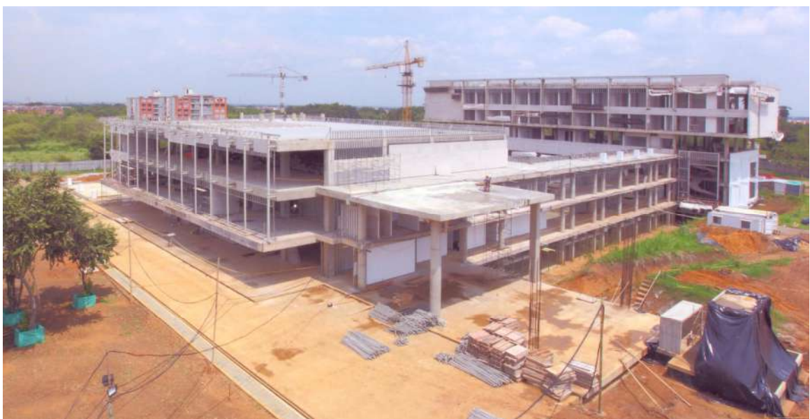
VISTA DE CONJUNTO DEL NUEVO HOSPITAL
