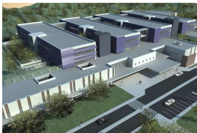
VISTA DEL CONJUNTO DEL NUEVO HOSPITAL DE ALCAÑIZ
