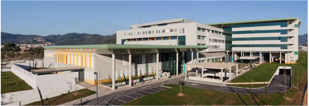
ALZADO SUR DEL HOSPITAL EN EL QUE SE APRECIA EL AREA DE PSIQUIATRIA Y HOSPITALIZACIÓN
