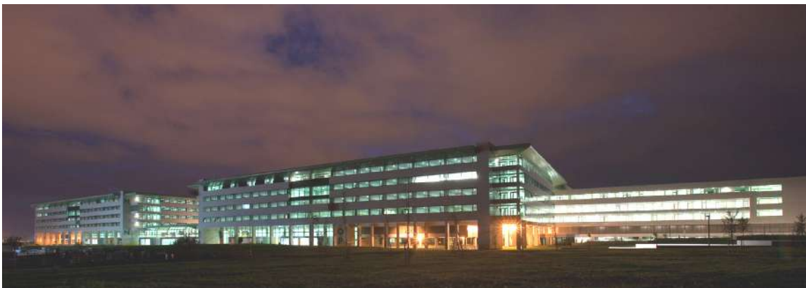
VISTA NOCTURNA AREA DE HOSPITALIZACION
